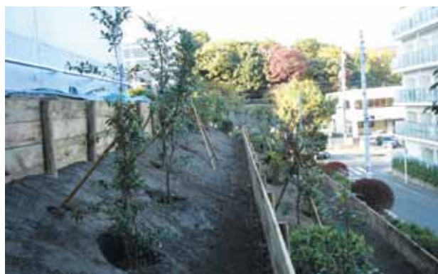
法面災害復旧後施工例
