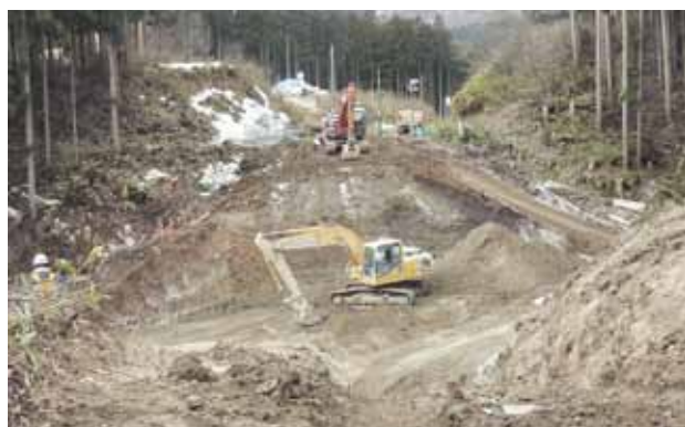
東日本大震災線路崩壊復旧工事
